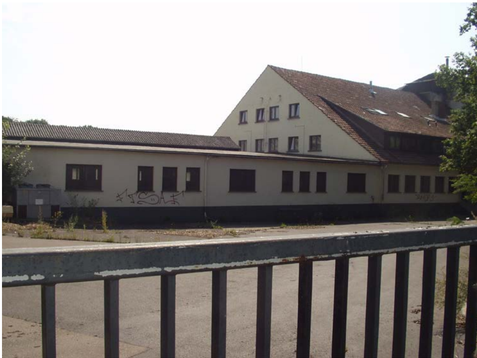
Vollständig versiegelter Betriebshof
